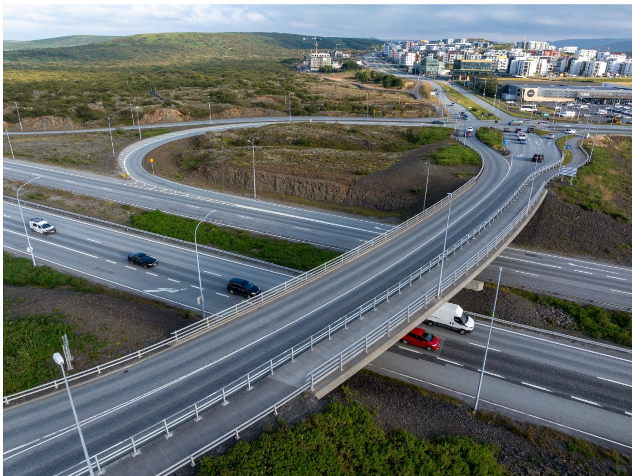
Vegrið við gangstétt á brú við Kaptún yfir Reykjanesbraut.
