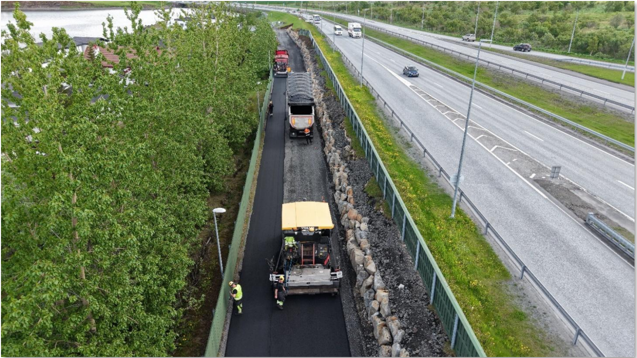
Framkvæmdir norðan við undirgöng við Arnarneshæð. Framkvæmdir langt á veg komnar.
