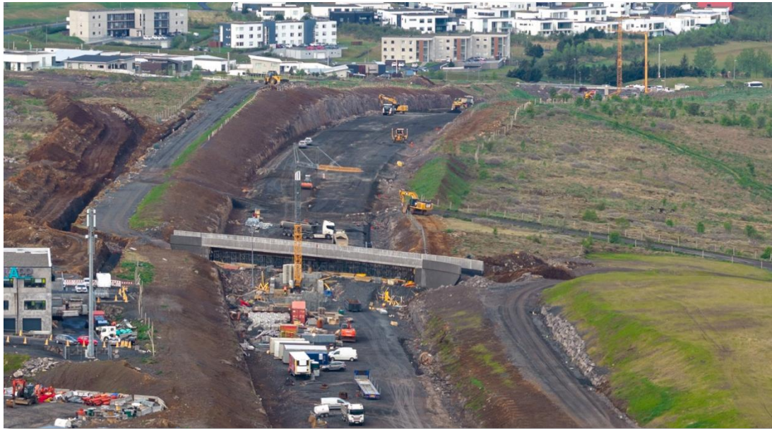
Vegstæði Arnarnesvegar sunnan Vatnsendavegar og nýja göngu- og hjólabrúin yfir Arnarnesvegi.
