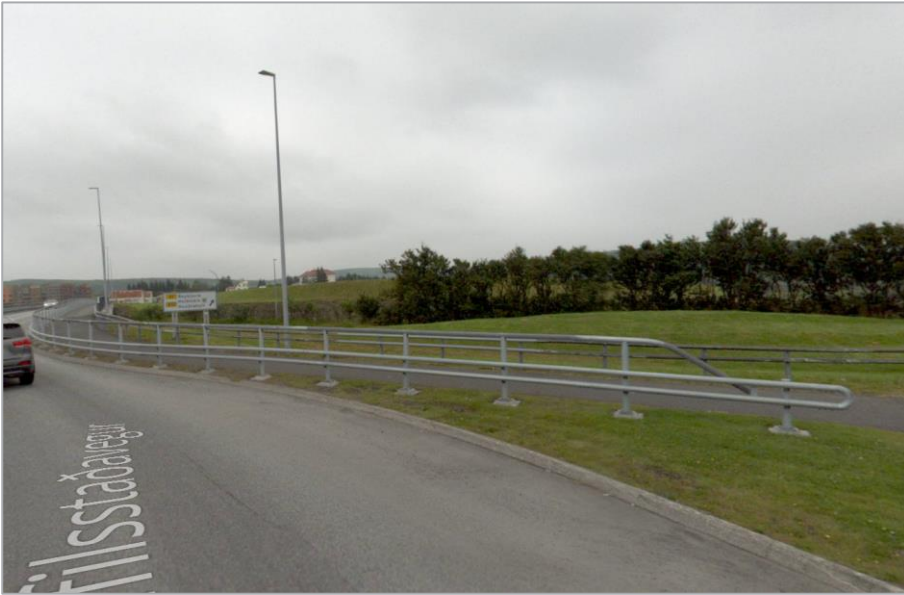
MYND 7 Vegrið með handriði á brú við Vífilsstaðaveg fyrir ofan Reykjanesbraut í Garðabæ.
