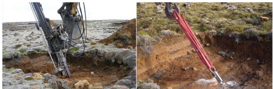
Mynd 2. Til vinstri sést hvar borað er fyrir bergbolta. Myndin til hægri sýnir bergboltapröfun.
