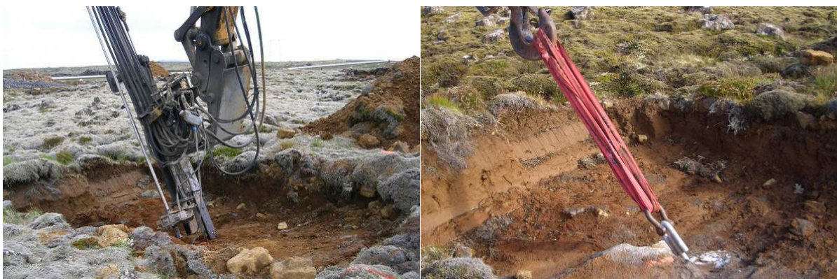
Mynd 6.6 Til vinstri sést hvar borað er fyrir bergbolta. Myndin til hægri sýnir bergboltaprófun.
