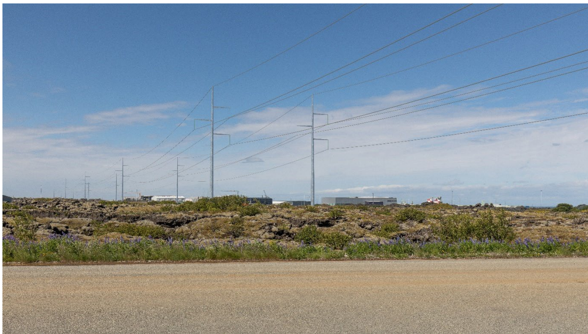
Mynd 6.4 Dæmi um einpóla mastur. Líkanmynd nærri Hraunhelli í Hafnarfirði.
