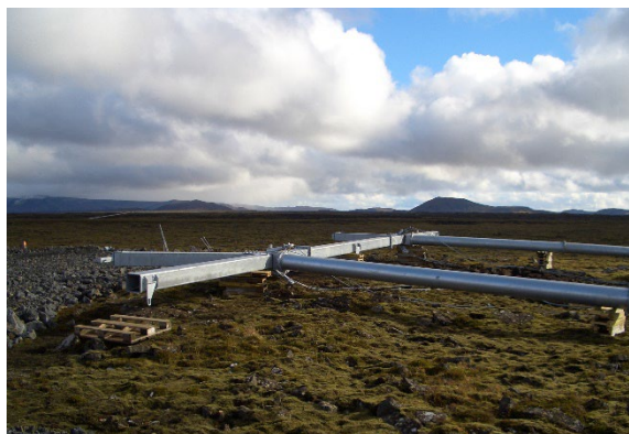
Mynd 6.8 Vinna við samsetningu og reisingu stagaðs burðarmasturs af M-gerð með jarðvírseyrum. Myndirnar eru frá byggingu Reykjaneslínu 1.
