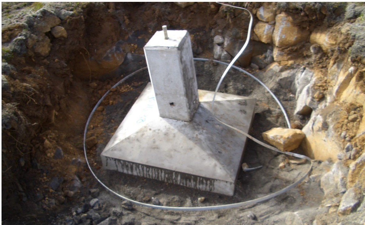
Mynd 6.5 Forsteypt undirstaða M-masturs (valkostur A). Jarðskautsborði úr stáli er lagður ofan í holuna og svo tengdur við mastur þegar búið er að reisa. Eftir er að fylla að undirstöðunni.
