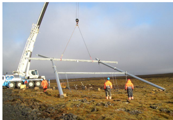
Mynd 6.8 Vinna við samsetningu og reisingu stagaðs burðarmasturs af M-gerð með jarðvírseyrum. Myndirnar eru frá byggingu Reykjaneslínu 1.
