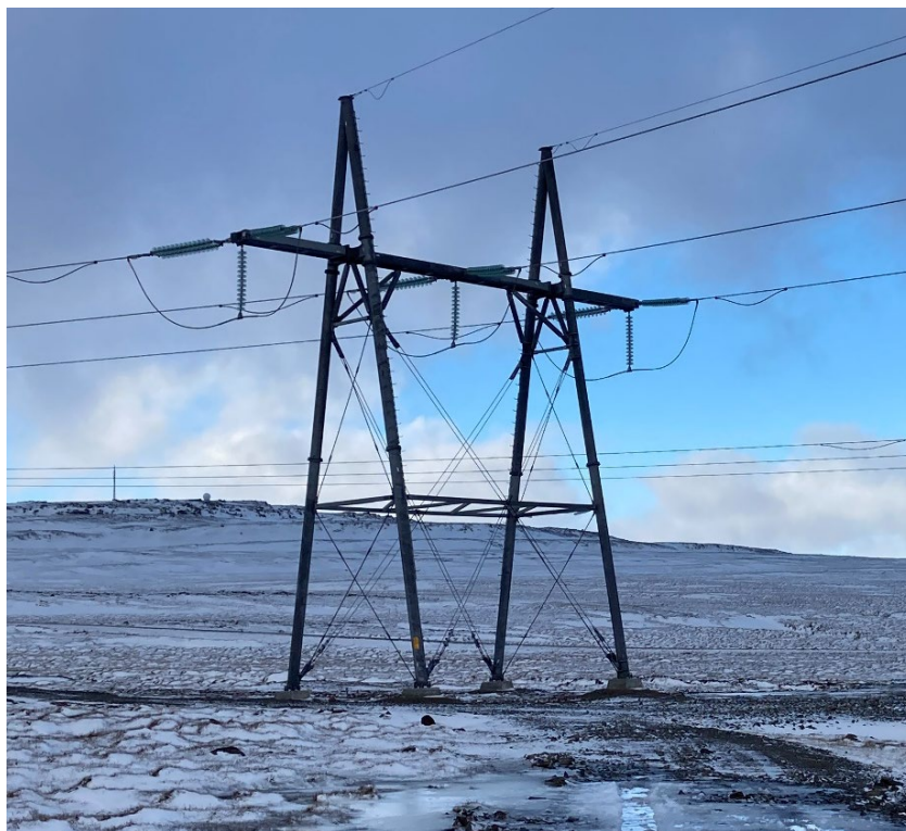
Mynd 6.3 Dæmi um enda-/hornmastur úr stálörum.
