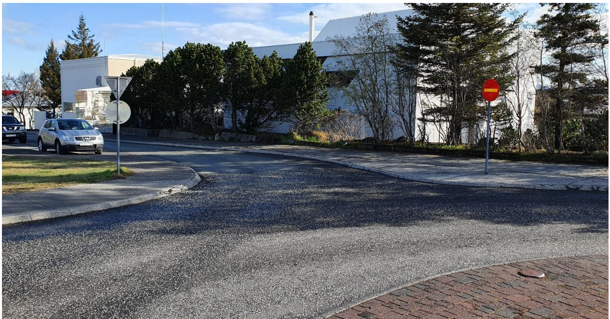
Mynd 2 - Horft frá hringtorgi inn Öldugötu. Þarna vantar gangbraut
