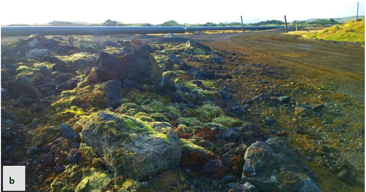
Mynd 5 a og b sýna dæmi um endurheimt hrauns og mosapembu á borteig við Hellisheiðarvirkjun. Hraungjalli og hraunsteinum er komið fyrir og mótað í samræmi við umlykjandi landslag. Mosatorfum og lausum mosa, sem haldið var til haga í upphafi framkvæmda, er komið fyrir í hraungjallinu til endurheimtar á mosapembum.
