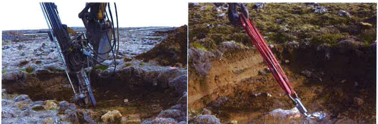
Mynd 4 Til vinstri sér hvar borað er fyrir bergbolta og myndin til hægri sýnir bergboltaprófun.
