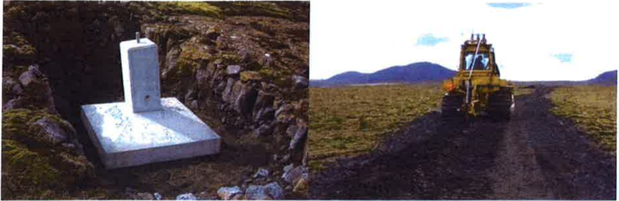
Mynd 3 Til vinstri má sjá forsteypta undirstöðu. M-masturs og hægri sést hvernig jarðskaut er plægt í vegslóð.
