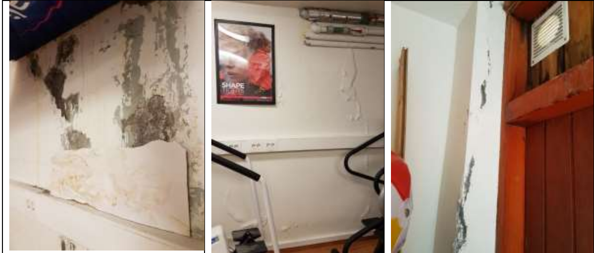
Mynd. Víða lekur inn í NA- hluta kjallara m.a. frá gluggum, hurð efri hæð, klórherbergi og gufubaði
