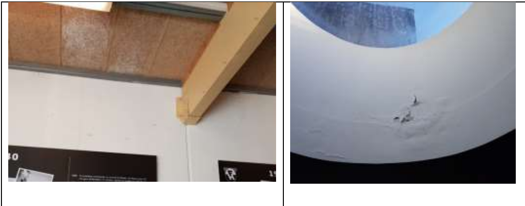
Mynd. Skipta þarf um þakdúk á tengibyggingu, lekur inn frá lofti. Víða þarf að mála og laga eftir leka.
