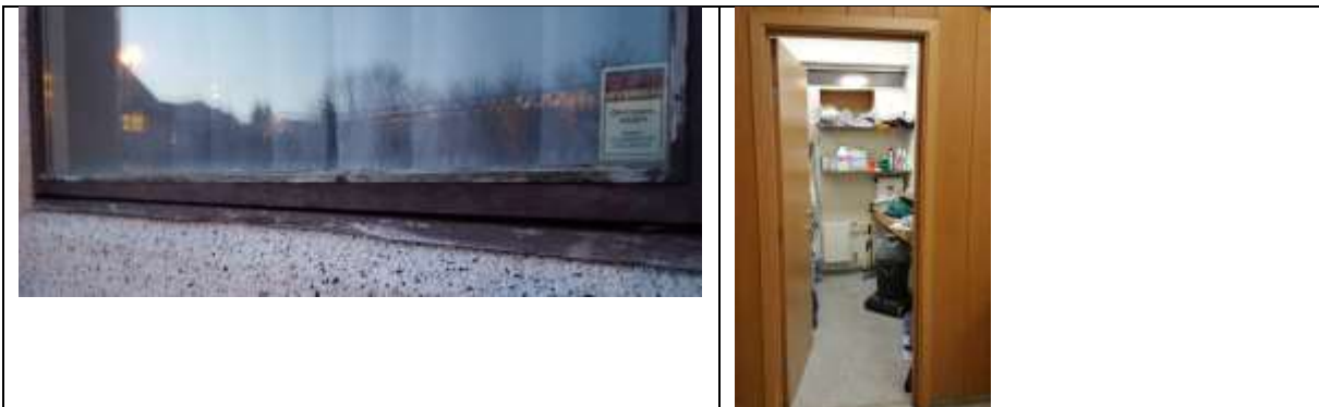
Mynd. Nánast alla glugga þarf að laga eða skipta út vegna leka og fúa. Breyta ræstiherbergi í klósett fyrir fatlaða.
