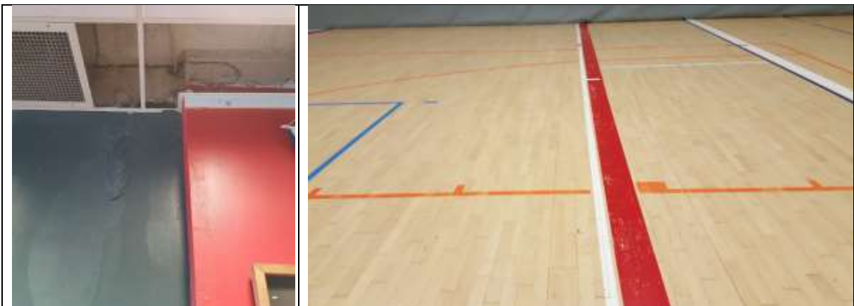
Mynd. Víða þarf að mála eftir leka. Matta og lakka þarf gólf á 2ja ára fresti, sem og laga merkingar
