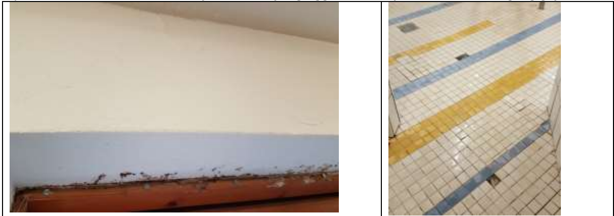
Mynd. Hurð út í garð hefur lekið lengi. Víða þarf að lagfæra gólfplisar.
