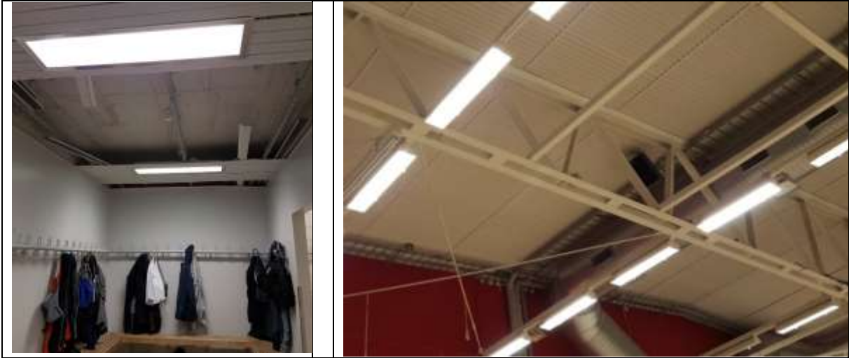
Mynd. Álstrimlaloft eru víða illa farin. Leki er frá þaki í íþróttasal
