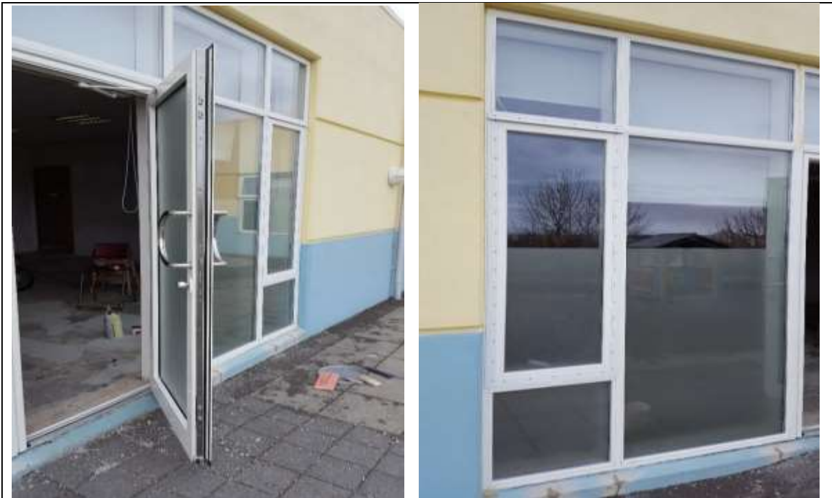
Mynd. Útihurð komin með 5 punkta læsingu og áfellur skrúfaðar á við opnanleg fög.
