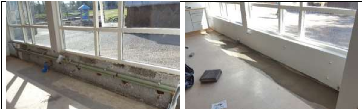
Mynd. Pússning og einangrun var fjarlægð undir glugga og veggurinn sótthreinsaður vegna myglu. Gólfúkur við gluggan var einnig fjarlægður og undirlagði hreinsað áður en nýr úkur var lagður.
