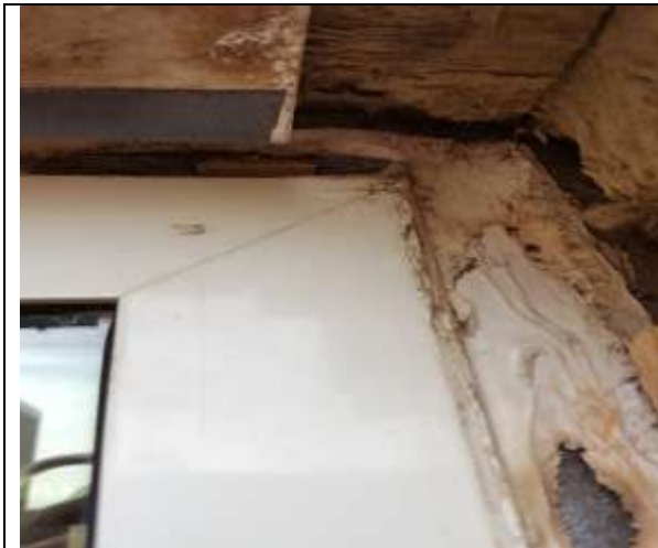
Mynd. Kítta meðfram útidyrhurð var óþétt. Flasningar á portvegg hefðu þurft að ná yfir allan portvegginn en þar skilar vatn sér inn í klæðninguna.
