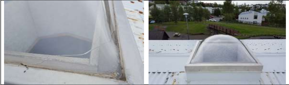
Mynd. Sprunga var komin í gler og þéttingar í ólagi. Sérsmíða þurfti nýja þakglugga og þeir settir í.
