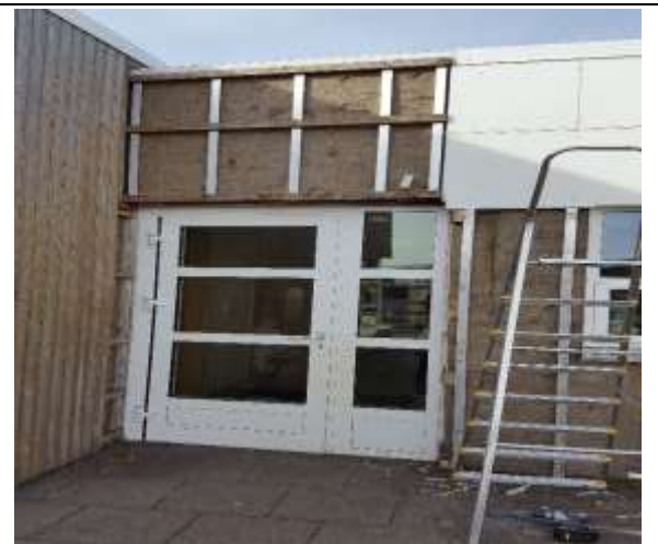
Mynd. Kítta meðfram útidyrhurð var óþétt. Flasningar á portvegg hefðu þurft að ná yfir allan portvegginn en þar skilar vatn sér inn í klæðninguna.
