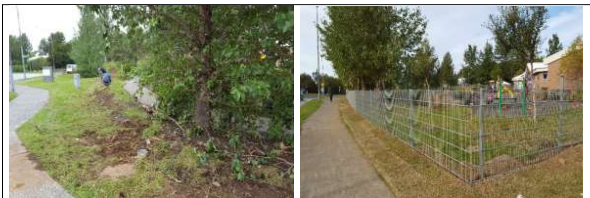
Mynd. Fúin timburgirðing var fjarlægð og sett járngríðing í staðin.
