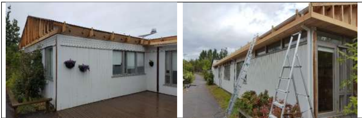
Mynd. Þakkantur endurbyggður og loftunarrörum komið fyrir í hvert sperrubil.
