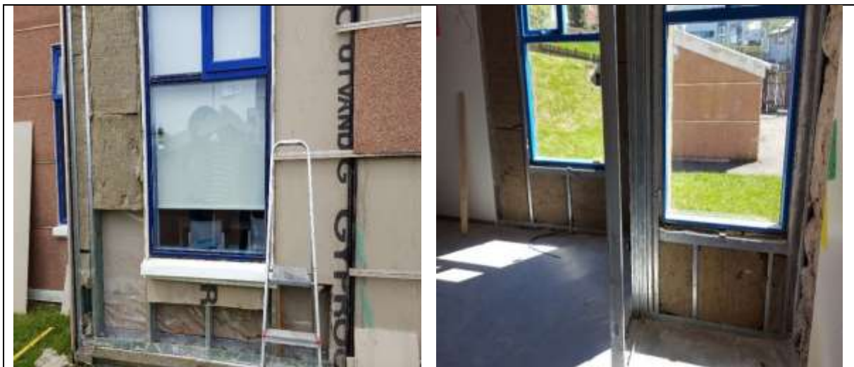
Mynd. Veggur við leikstofu opnaður og í ljós kom mikill raki undir glugga. Veggir opnaðir innanfrá og í ljós kom að ekki var gengið rétt frá rakavarnarlagi.
