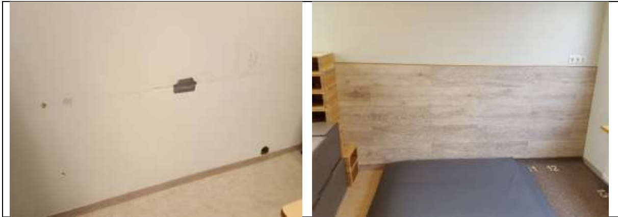
Mynd. Í leikstofum voru göt í veggjum. Veggir voru parketlagðir um meter frá gólfi.
