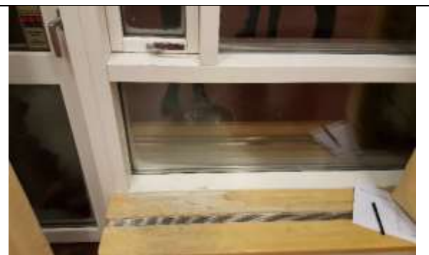
Mynd. Loftraufar eru á opnanlegum fögum og inn um raufarnar lekur inn.
