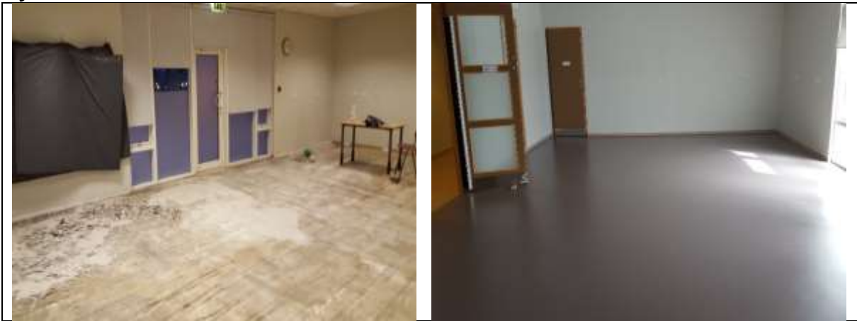
Mynd. Gólfdukkur tekinn af og nýr lagður eftir endurbætur á gluggum og hurðum.
