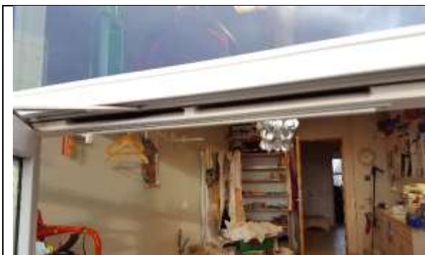
Mynd. Loftraufar eru á opnanlegum fögum og inn um raufarnar lekur inn.
