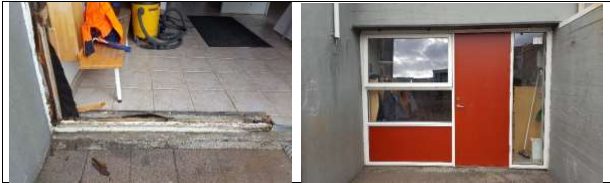
Mynd. Útihurðir endurnýjaðar, fúnar í gegn.
