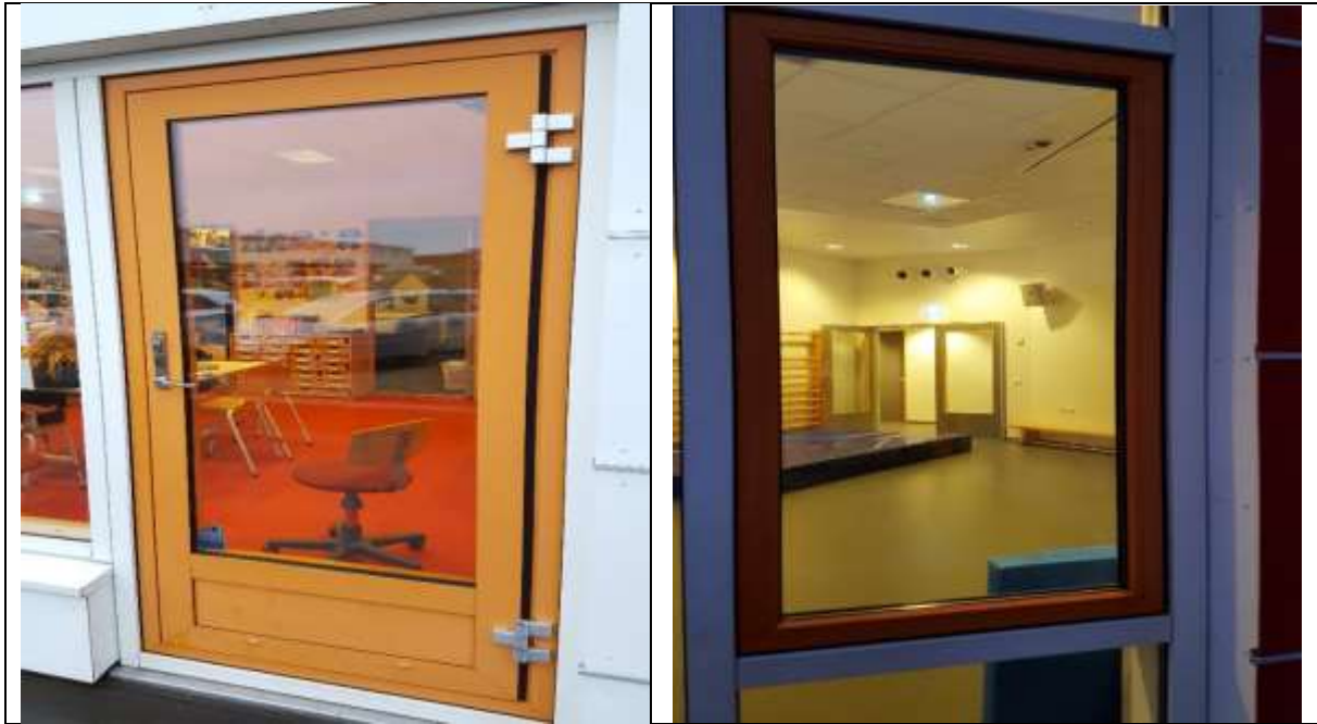
Mynd. Útihurðir eru úr áli og með eins punkta læsingu. Gluggar eru einnig úr áli en nær allar hurðir og allir gluggar með opnanlegu fagi leka.
