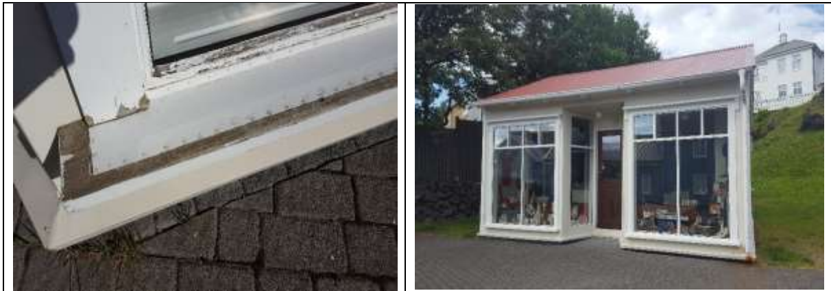
Mynd. Málning tréverks utanhúss var orðin léleg. Allt tréverk var endurmálað og borið á útidyr.
