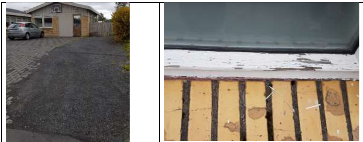
Mynd. Helluleggja þarf hluta af bilaplani. Mála þarf alla glugga að utan
