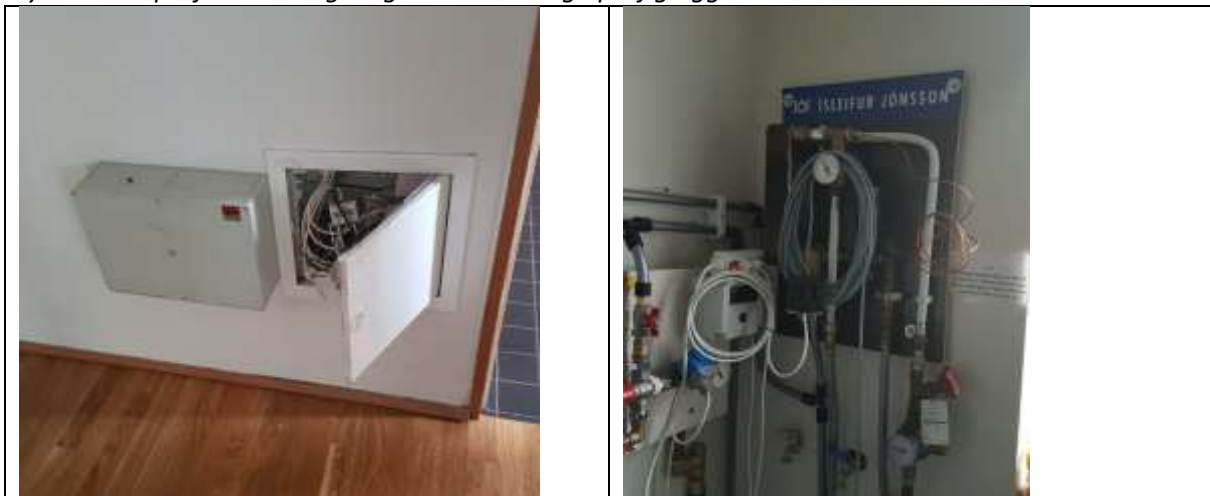
Mynd. Laga þarf lokun á töflum (veikstraum). Fer að koma tími á varmaskipti á neysluvatninu.
