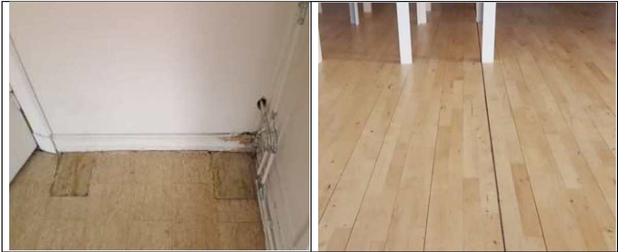
Mynd. Á 2. hæð er þörf á að yfirfara gólfefni og endurnýja að hluta. Parkett á sýningarsal þarfnast viðgerðar.
