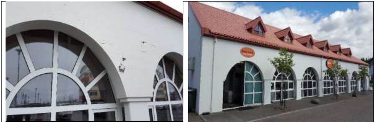
Mynd. Steypuskemmdir voru lagaðar og steptir fletir og gluggar endurmálaðir.
