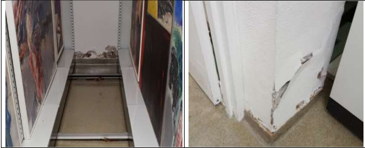
Mynd. Í kjallara eru rakavandamál víða í veggjum. Fjarlægja þarf listaverk úr kjallararými.
