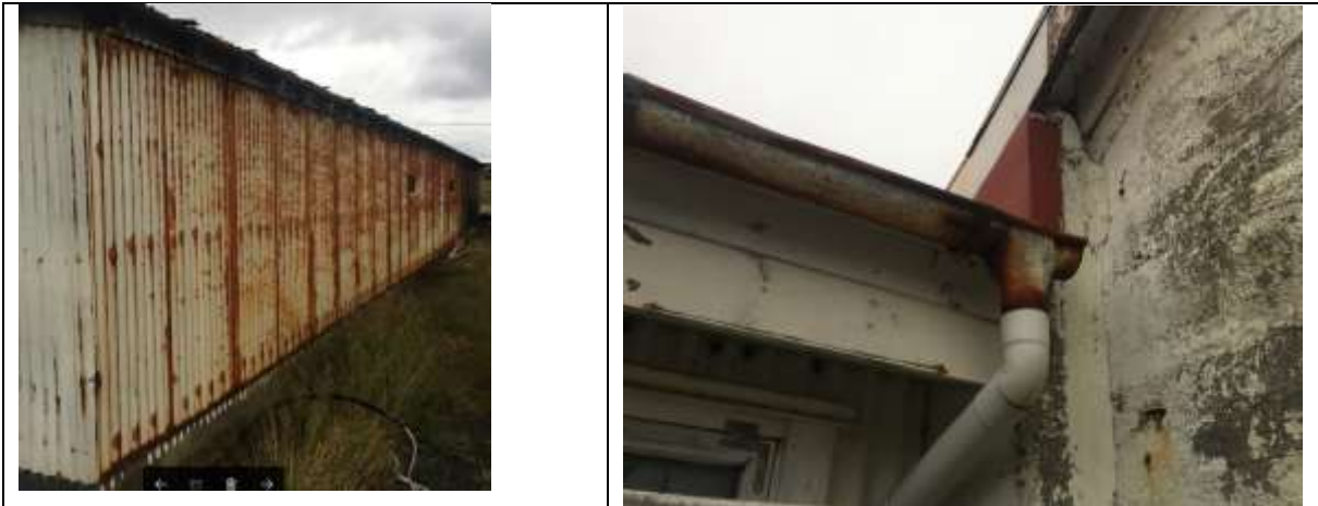
Myndir. Setja þarf nýtt bárujárn og rennur og niðurföll á hluta húss. Mála þarf húsið.
