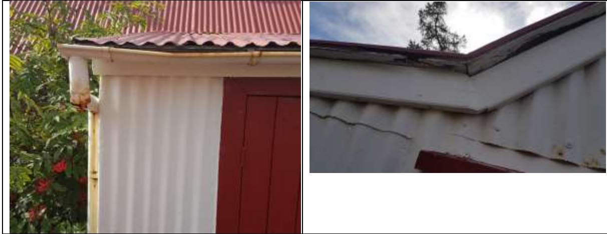
Mynd. Rennur og niðurföll orðin léleg. Þakkanntur orðinn fúinn á mörgum stöðum.
