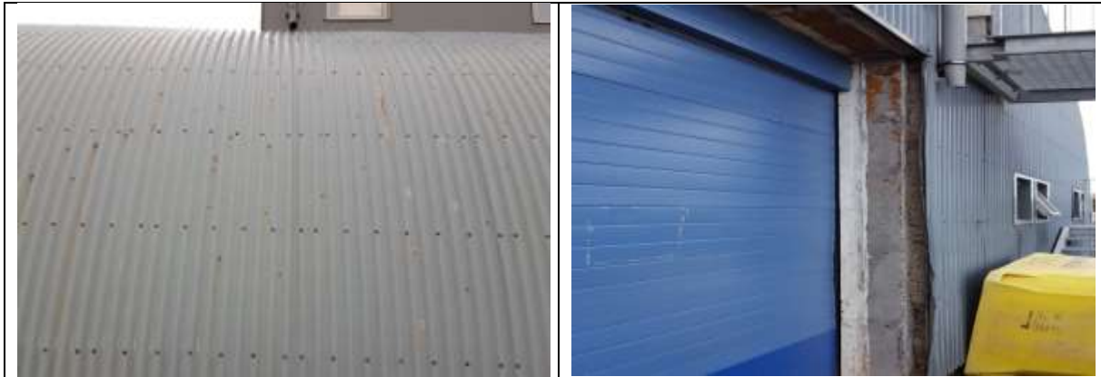
Myndir. Utanhússklæðning er farin að ryðga, sem og festingar. Eftir að ganga frá flasningum.
