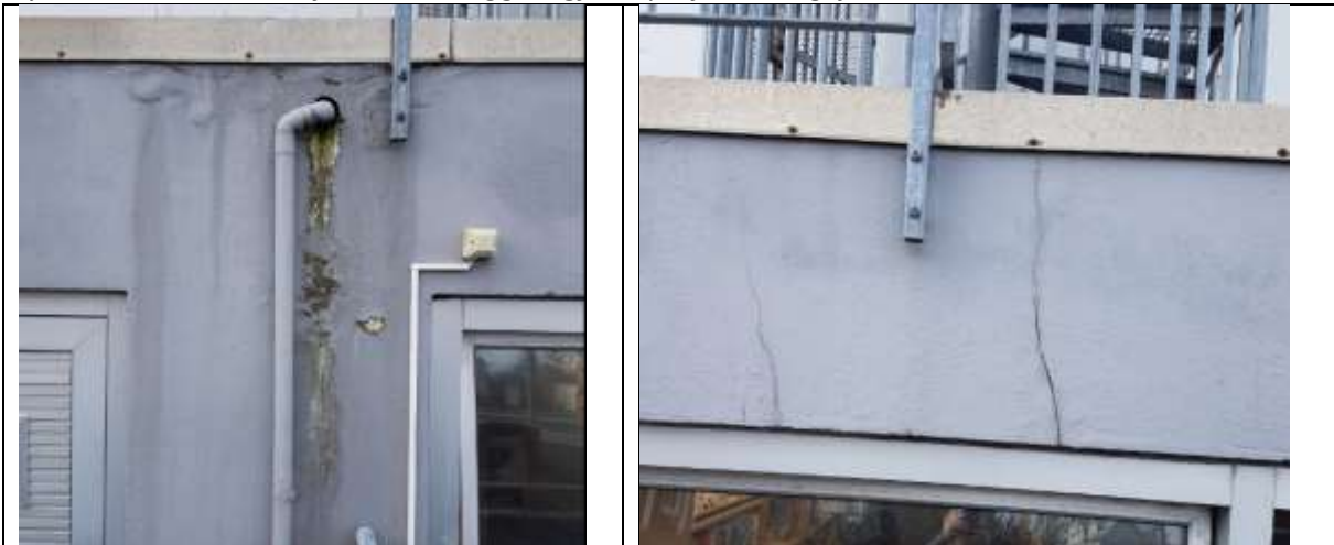
Myndir. Niðurfall frá þaki tekur ekki við öllu vatni. Sprunguviðgerða er þörf á steiptum veggjum.
