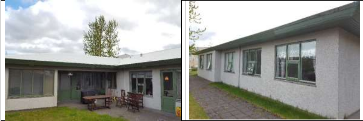
Mynd. Nauðsynlegt er að endurmála þakjárn. Einnig þarf að endurmála tréverk reglulega.
