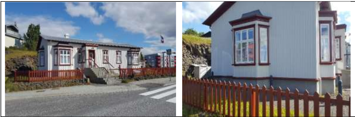
Mynd. Allt tréverk var endurmálað utanhúss og bárujárnsklæðning veggja blettuð.
