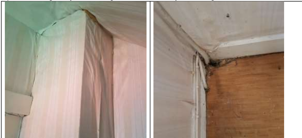
Mynd. Lekið hefur inn með strompi í langan tíma. Veggefni orðið uppbólgnað. Dúkur á gólfi orðinn lélegur. Farinn að springa. Raki í hornum.
