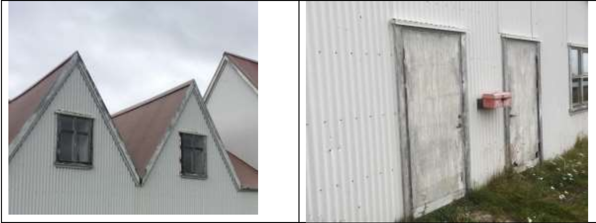
Myndir. Mála þarf alla glugga og tréverk á húsinu. Hluti af gluggum og hurðum þarf að skipta út.
