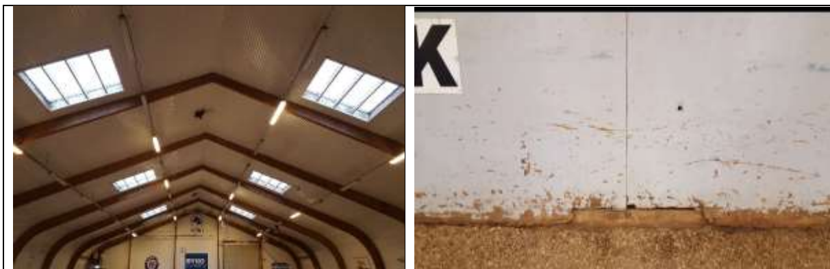
Myndir. Í reiðsal er tölverður leki með þakgluggum. Endurnýja þarf spjöld inni í reiðsal.
