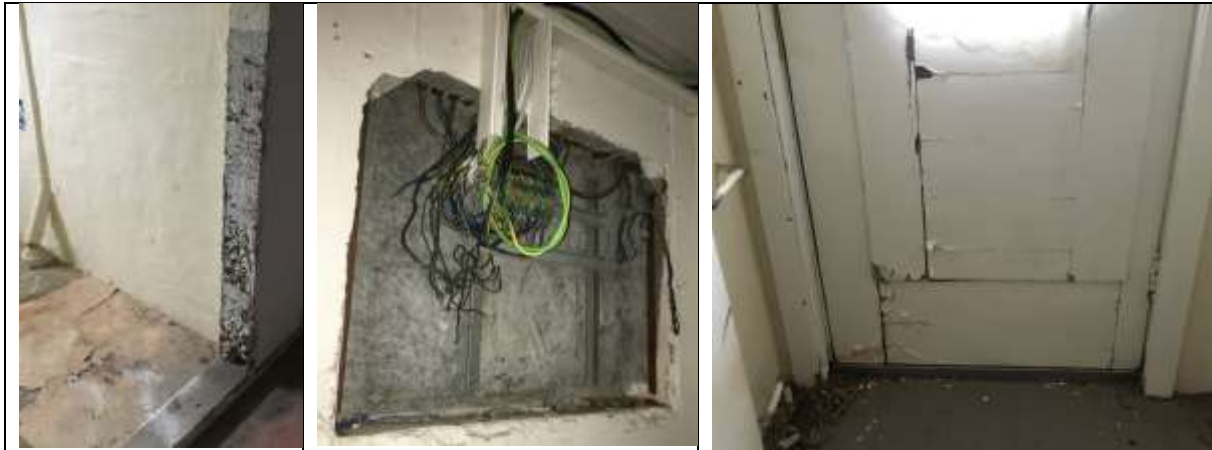
Myndir. Vantar hurðar og gólfefni að mestu í húsið. Setja þarf upp rafmagnstöflu og draga í fyrir rafmagn. Allar útihurðir komnar á tíma.
