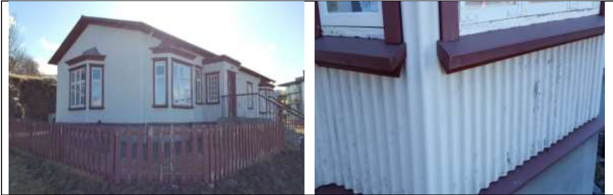
Mynd. Málun á tréverki er fyrirbyggjandi aðgerð til að lengja líftíma. Þörf var á að bletta bárujárn.
