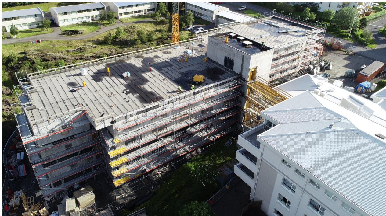
Vettvangsmynd 05.07.2018. ( Bygging er uppsteypt að frátöldum 6stk súlum 3.hæðar og plötu yfir 3.hæð og þakplötu tengingangs. Niðurlögn rakavarnarlags á þakplötu er nánast lokið ).
