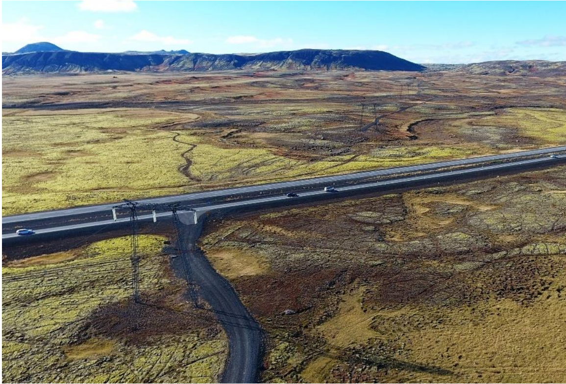
Mynd 20. Núverandi ásjón á Búrfellslínu 3, horft yfir Suðurlandsveg til suðvesturs.
