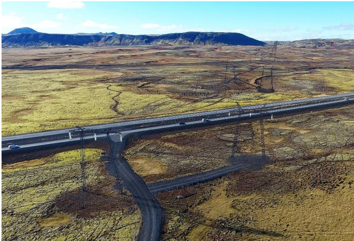
Mynd 21. Ásjón á Búrfellslínu 3 og Sandskeiðslínu 1 eftir byggingu þeirrar síðarnefndu, horft yfir Suðurlandsveg til suðvesturs.
