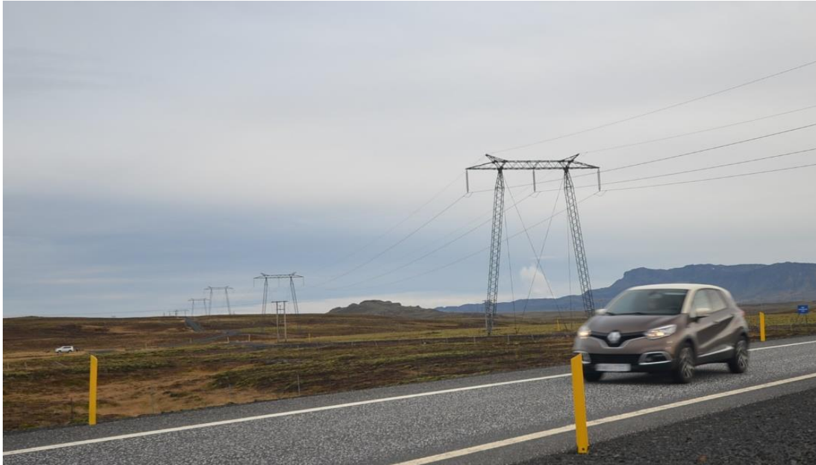
Mynd 22. Núverandi ásjúnd á 220 kV Búrfellslínu 3, horft frá Suðurlandsvegi til norðausturs.
