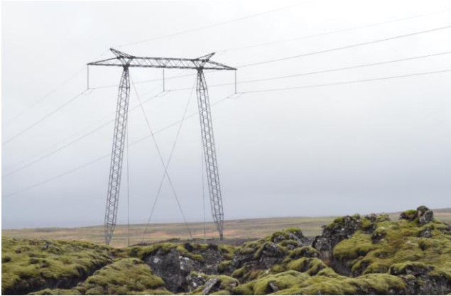
Mynd 18. Möstur í Sandskeiðslínu 1 verða flest stöguð og svipuð og ofangreint mastur í samsíða línu, Búrfellslínu 3.
