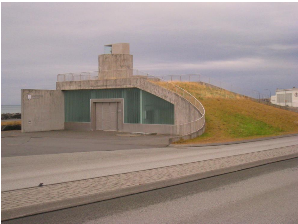
Nýleg dælustöð við Norðurgarð
