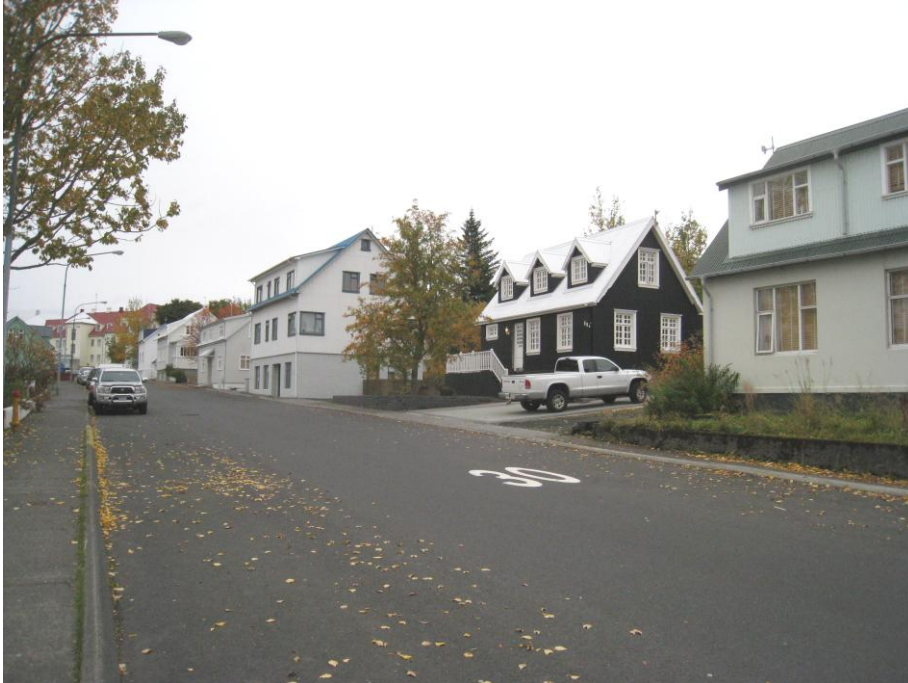
Bárujárnshús við Suðurgötu.
