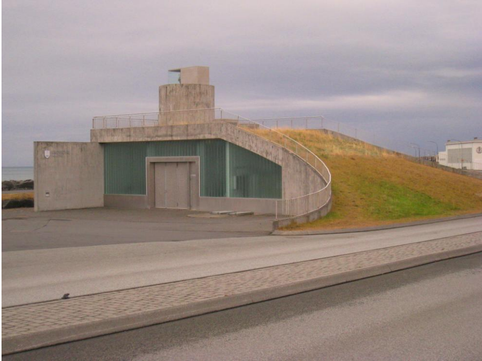
Nýleg dælustöð við Norðurgarð
