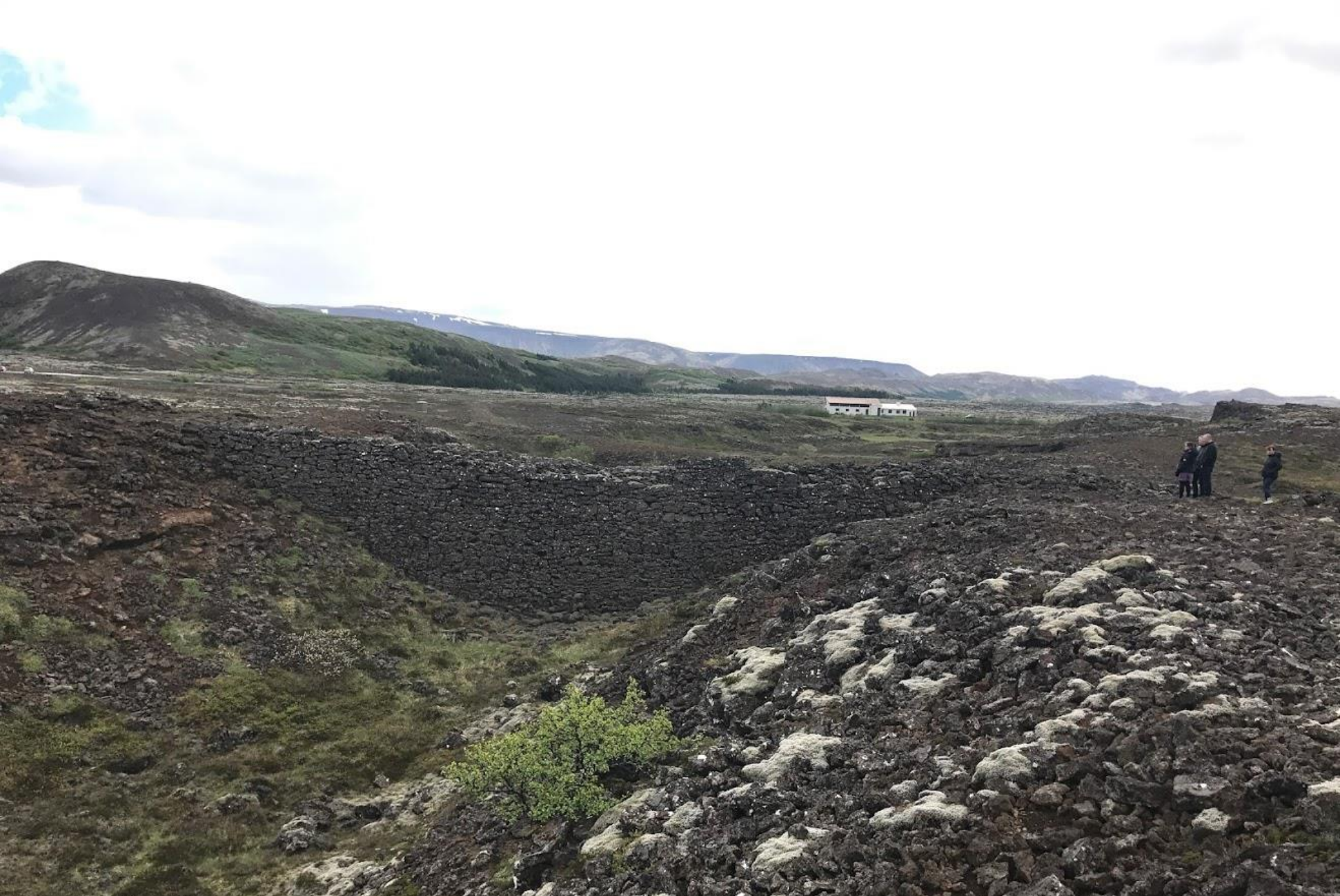
Ljósmynd af vatnsstokkshleðslu yfir Lambagjá
