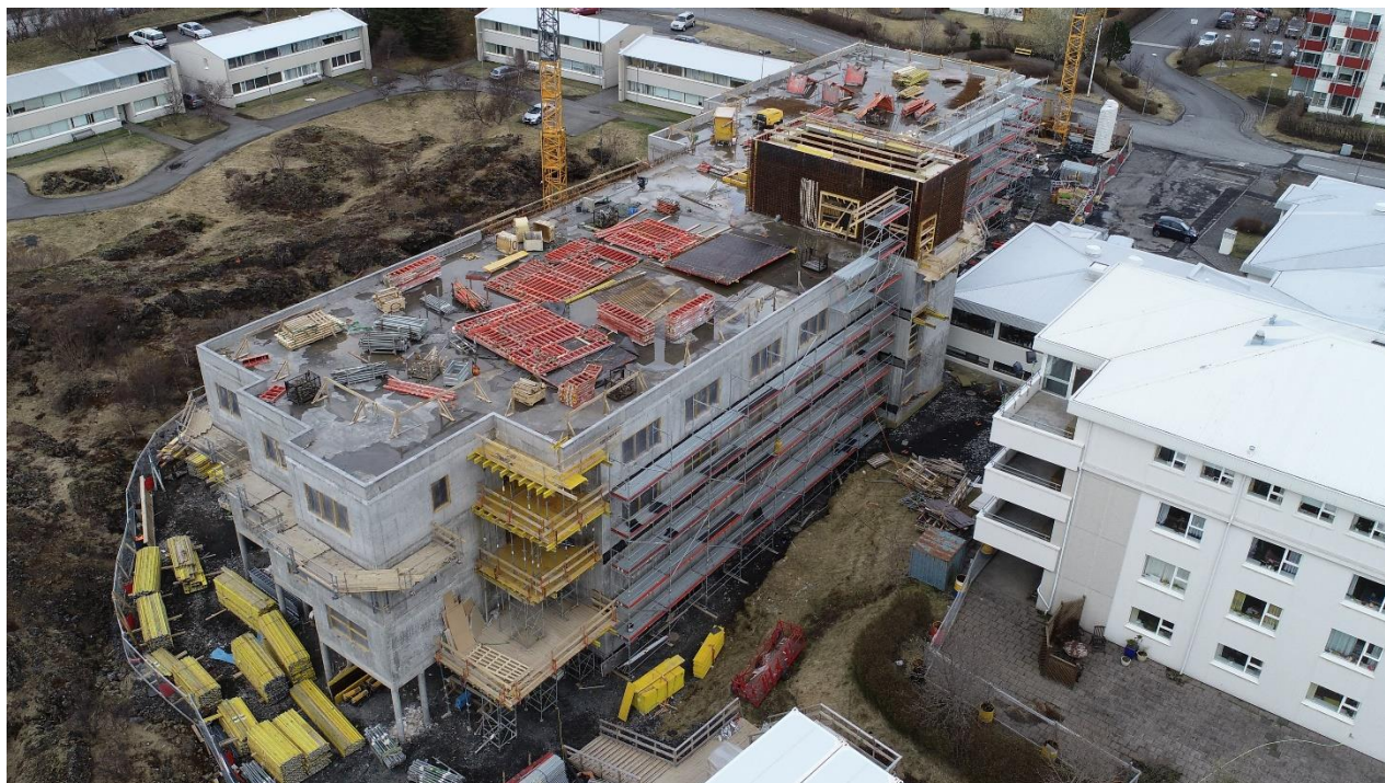
Vettvangsmynd 19-04-2018. ( Langt er komið að steypa portveggi þakplötu, unnið að uppslætti veggja 4.hæðar
