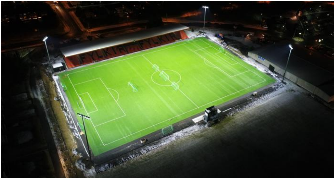
Mynd 13.1 Flóðljúsing við Víkings- og Fylkissvæðin sem er sambærileg og á Haukasvæðinu. Hönnun flóðljúsingar miðar að því að valda sem minnstri ljósmengun utan við völlinn.
