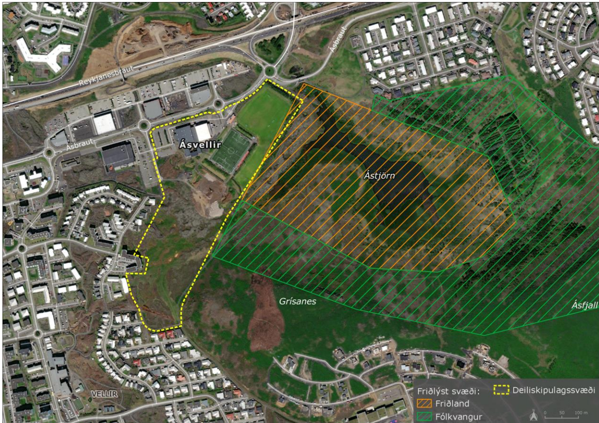
Mynd 3.1 Yfirlitsmynd af afmörkun deiliskipulagssvæðis, ásamt friðlandi Ástjarnar og fólkvangs við Ásfjall.
