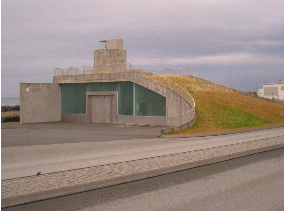
Nýleg dælustöð við Norðurgarð
