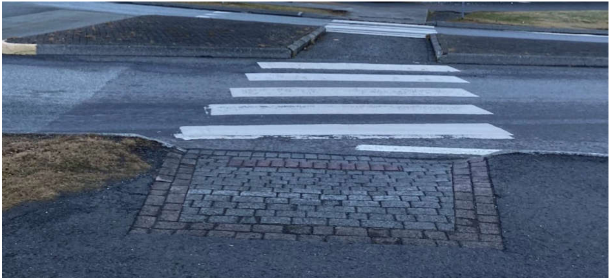
MYND 11 Eldri tegund af áherslufletum útbúin með helluröð.
