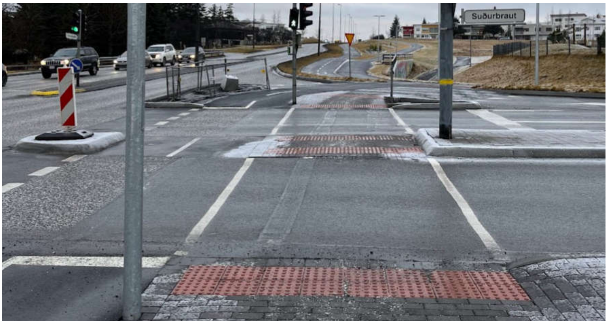
MYND 12 Áherslufletir úr 30x30 cm einingum með upphleyptum hnöppum.
