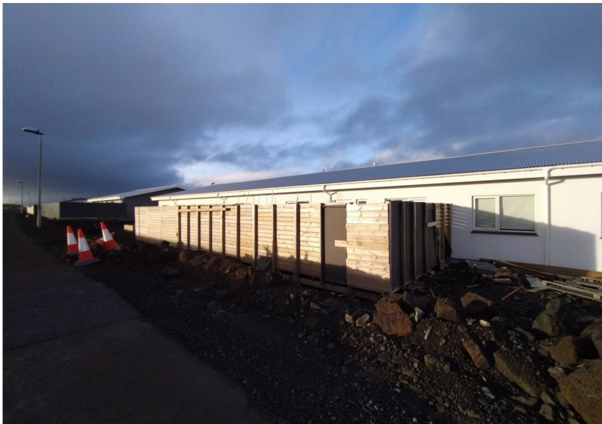
MYND 4. GRINDVERK VIÐ HÚS NR. 39 VIÐ HNOÐRAVELLI. MYNDIN ER TEKIN UM KL. 14 ÞANN 11. NÓVEMBER 2021. GINDVERK ERU ÓSAMÞYKKT.
